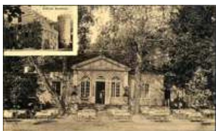
8633 Rosenau Park-Restaurant gelaufen 18.9.1929
